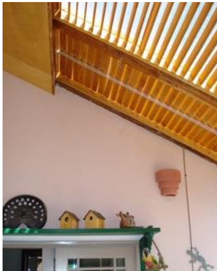
Рис. 7. Приклад контролю потрапляння сонячних променів через жалюзі в кімнату [1]
