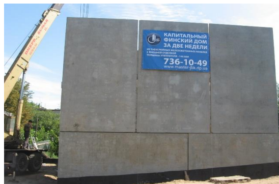
Рис. 3. Будівництво котеджу зі збірних тришарових залізобетонних панелей за фінською технологією
