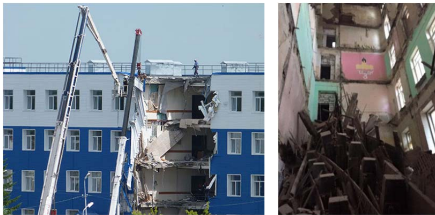
Рис. 1.6. Повреждение зданий: а) – вследствие некачественного ремонта (г. Омск, 2015 г.); б) – при проведении ремонта (г. Киев, 2016 г.)
