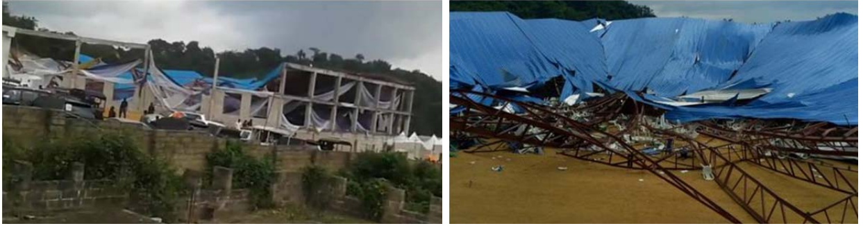
Рис. 1.5. Обрушение гибкой крыши церкви в Нигерии (2016 г.): а) – остатки церкви; б) – разрушенная крыша
