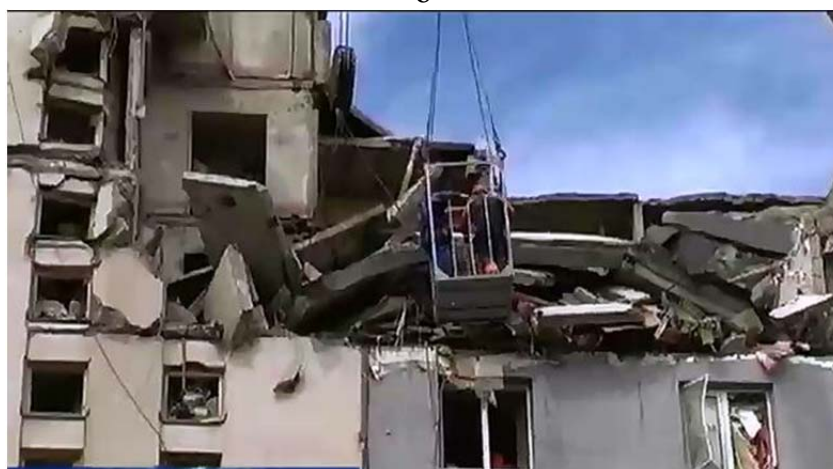
Рис. 3.3. Последствия взрыва газа верхней части 10 - этажного панельного дома в г. Николаев (2014 г.):
