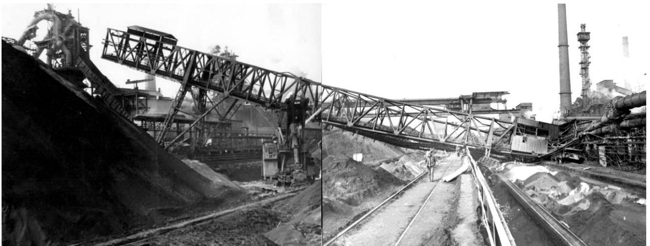
Рис. 2.5. Обрушение моста перегружателя решетчатого типа
