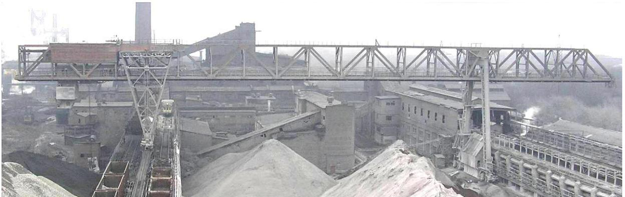
Рис. 1.1. Мостовой кран-перегрузатель решетчатой конструкции с шарнирной и жесткой опорами
