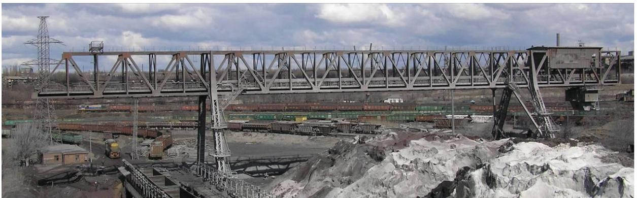
Рис. 1.2. Мостовой кран-перегружатель решетчатой конструкции с гибкой и жесткой опорами
