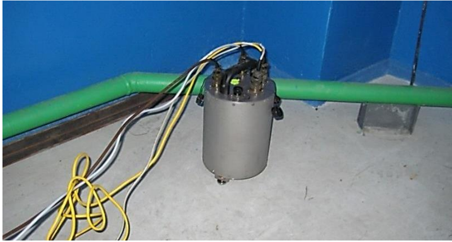
Рис. 3.7. Встановлення сейсмологічного обладнання на відмітках будівлі
