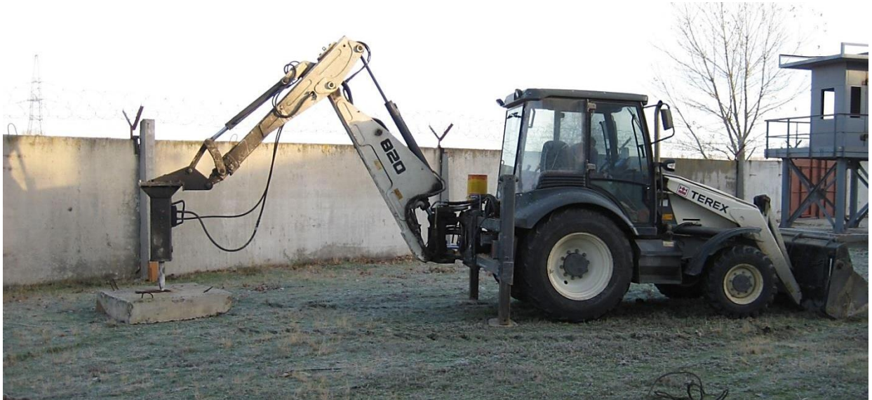
Рис. 3.9. Встановлення бетонолома та створення динамічного впливу
