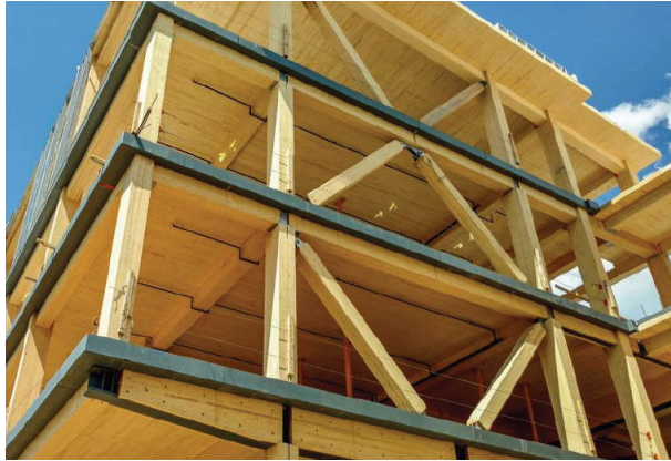
Рисунок 1.13 – Приклади використання клеєних інженерних виробів з деревини: а) будівля з каркасом клеєних дерев'яних елементів [118]; б) процес монтажу будівлі з CLT-панелей [119]
