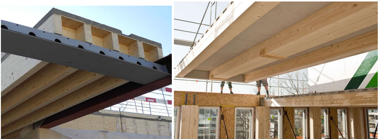
Рисунок 1.17 – Загальний вигляд деревозалізобетонного перекриття [157, 158]
