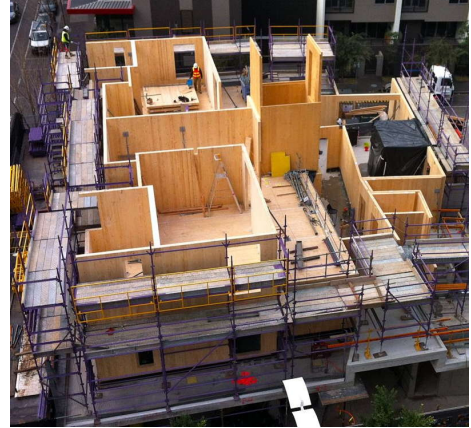
Рисунок 1.13 – Приклади використання клеєних інженерних виробів з деревини: а) будівля з каркасом клеєних дерев'яних елементів [118]; б) процес монтажу будівлі з CLT-панелей [119]
