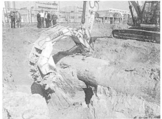
Рис. 3. Змінне обладнання до однокішшевого екскаватора для підкопування ґрунту під трубопроводом.
