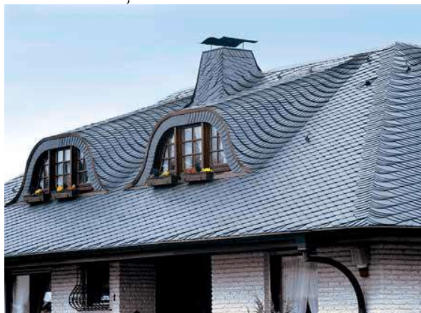
Рис. 3. Загальний вигляд сланцевої покрівлі
