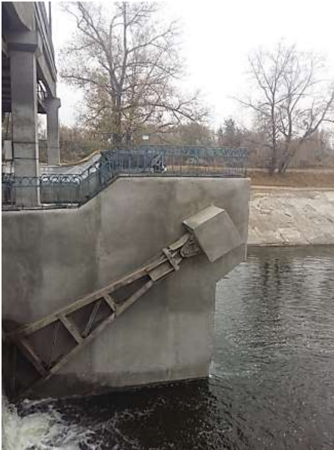
Рис. 5. Восстановленная поверхность устоя методом «сухого» торкретирования
