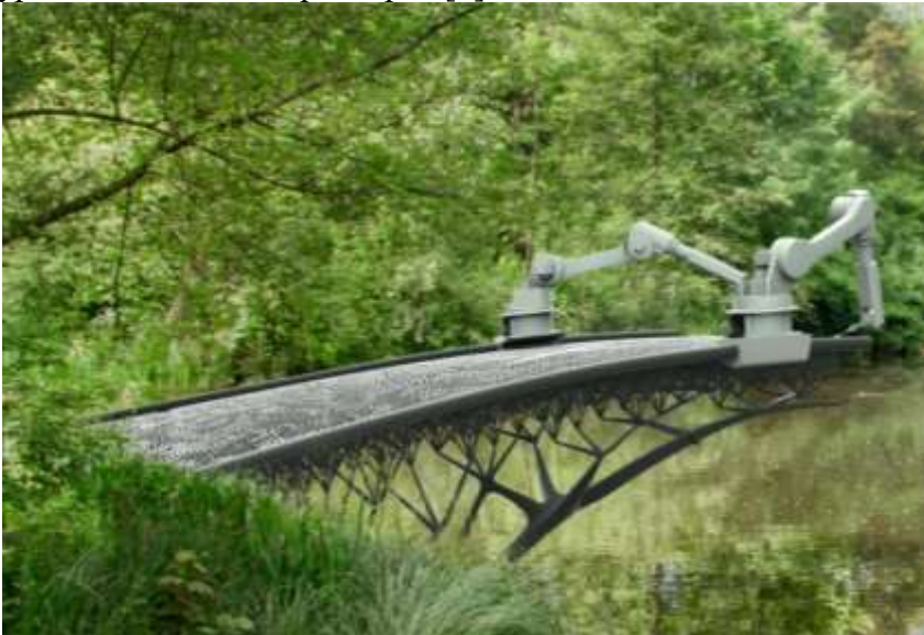
Рис. 2. Прототип металлического моста компании «MX3D», Нидерланды, 2015
