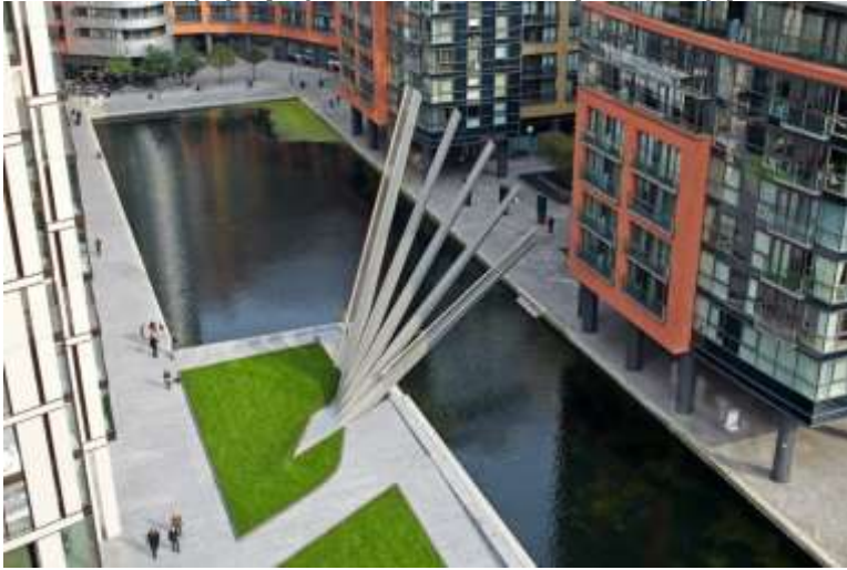
Рис. 1. Веерный мост; Knight Architects; 2014 г.; Paddington, London W2, United Kingdom
