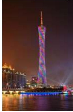
Рис. 8. Башня в Гуанчжоу
