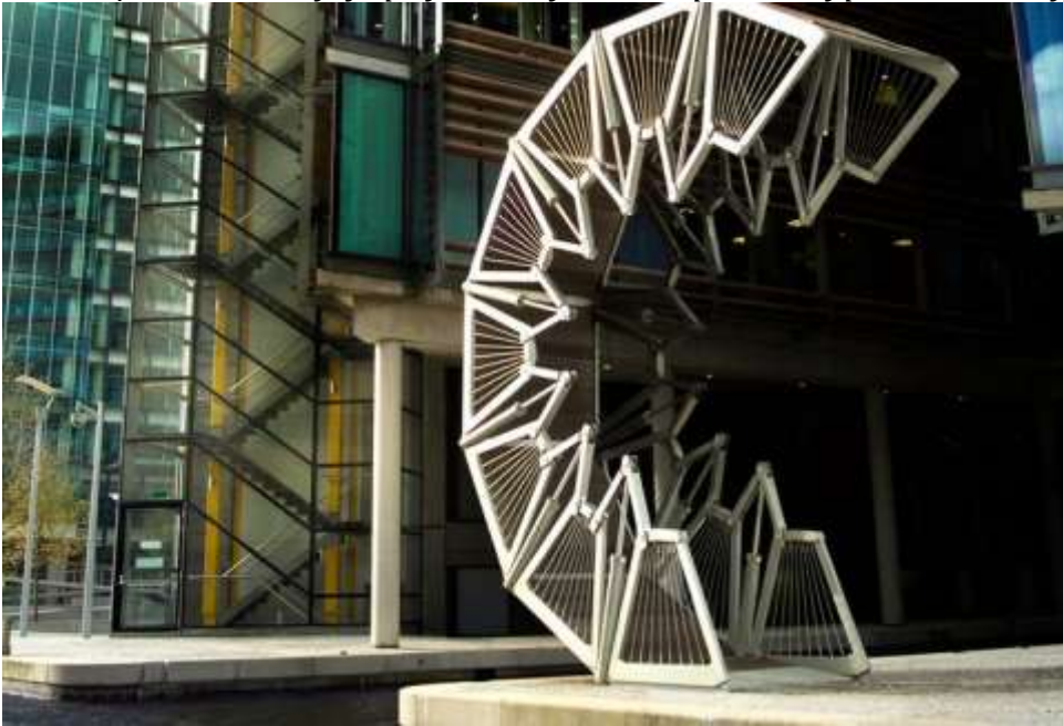
Рис. 6. Перекатывающийся мост в Лондоне, арх. – Томас Хитэ́рвик, 2004
