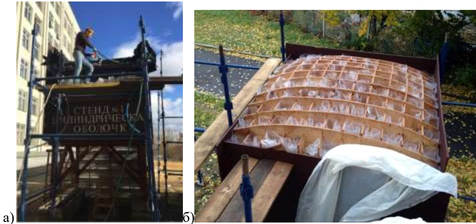
Рис. 4. Стеновые испытания оболочек: а) – подача воды в резервуар; б) – конструкция резервуара
