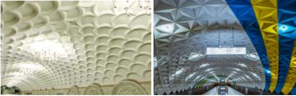
Рис. 5. Об'ємні залізобетонні елементи на станції «Спортивна» та «Київська»
