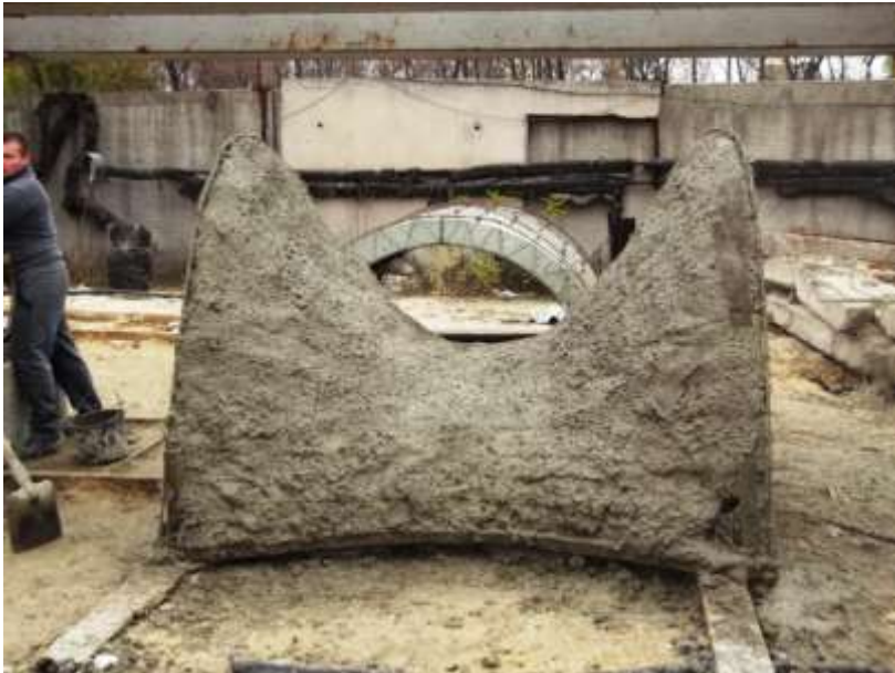
Рис. 3. Забетонированная оболочка способом мокрого торкретирования.
