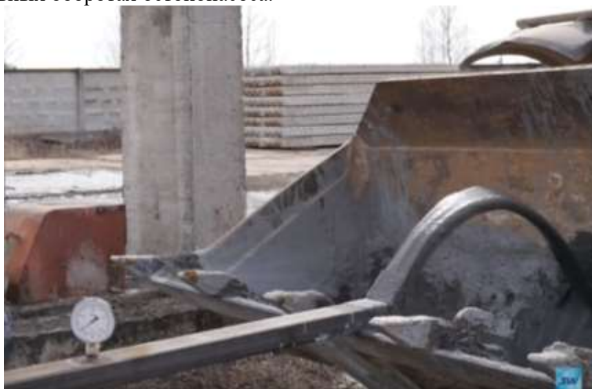
Рис. 5. Течение бетонной смеси на выходе из магистрали
