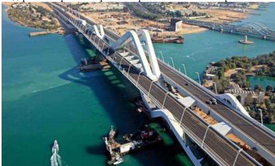
Рис. 3. Мост Шейха Зайда. Абу-Даби, ОАЭ (1997-2010)
