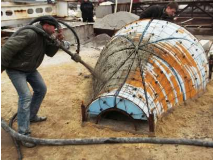
Рис. 2. Изготовление железобетонной оболочки способом мокрого торкретирования.
