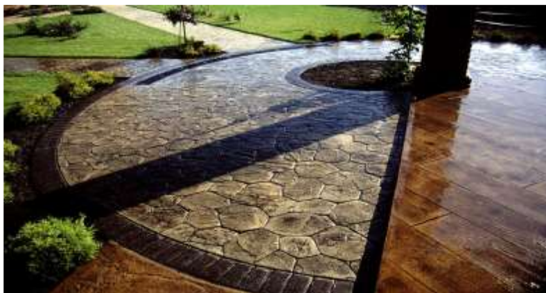
Рис. 2. Компания Современные технологии строительства STS Саратов Штампованный бетон.
