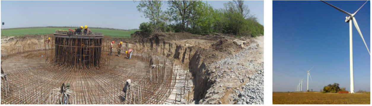
Рис. 1.3. Фундаменти під турбоагрегати Приморської вітроелектростанції.
