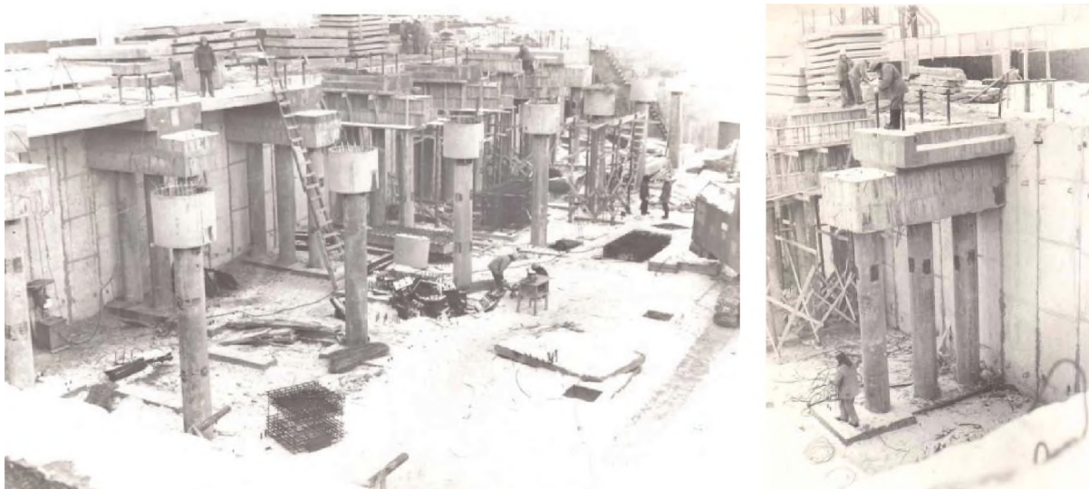
Рис. 2.1. Збірні підколонники з центрифугованих труб цеху розвантаження вагонів металургійного заводу ім. Дзержинського в м. Дніпродзержинськ (світлина Савицького М. В.).
