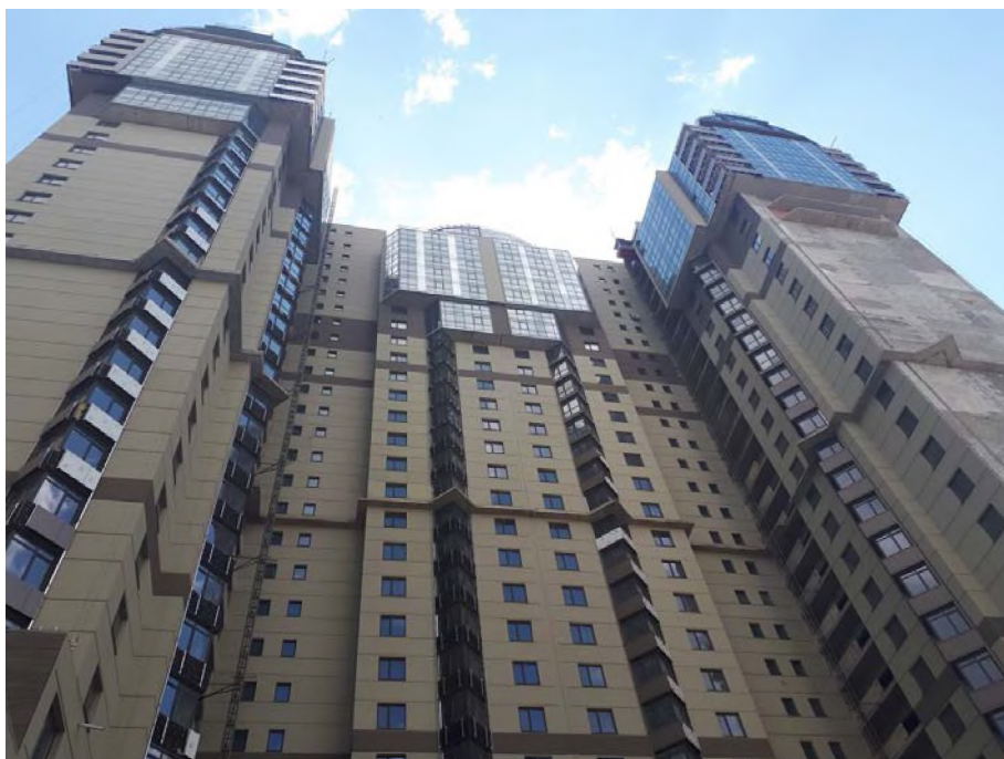
Рис. 4.17. Житловий 33-поверховий комплекс у м. Київ по вул. Драгомирова, 4а.
