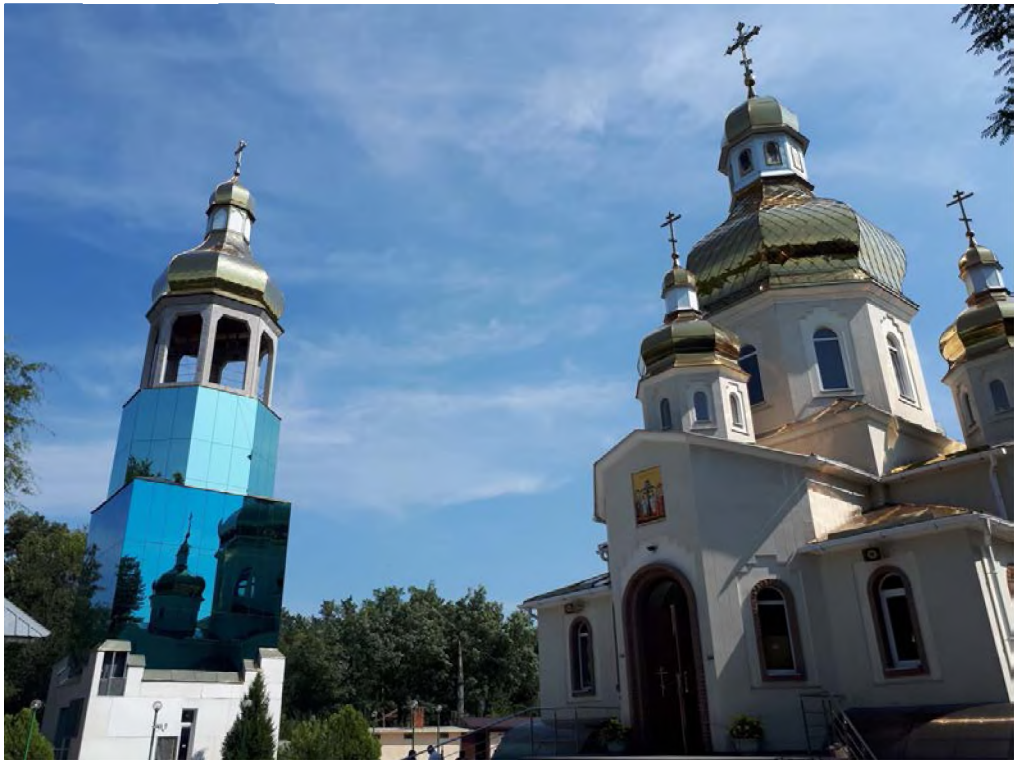
Рис. 4.19. Будівлі із збірного залізобетону. Храм та дзвіниця у с. Кіровське.
