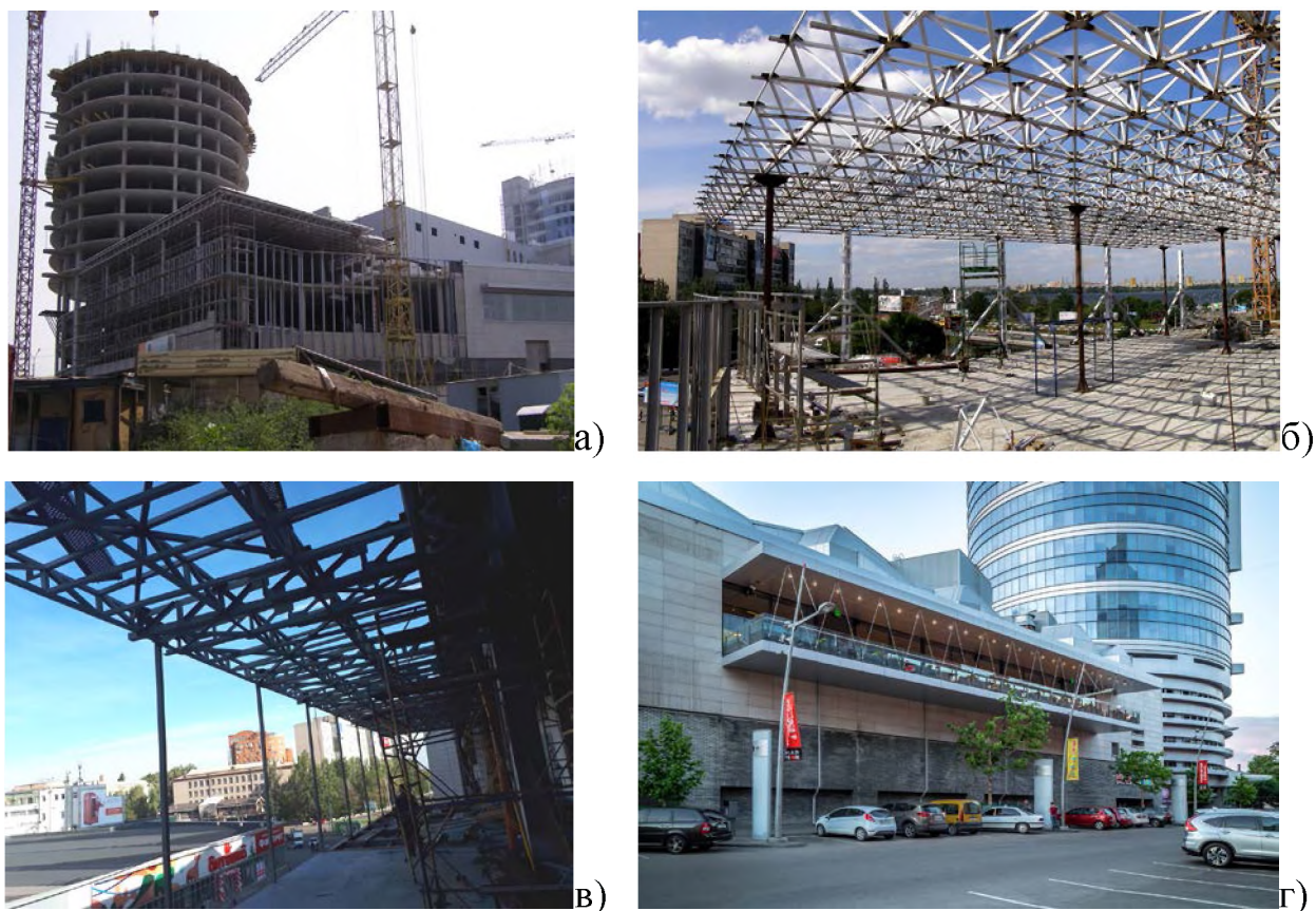
Рис. 4.10. «ТРЦ МОСТ-СІТІ» у м. Дніпропетровськ (2006-2007 рр.): а) на етапі зведення; б) структурне покриття ковзанки; в) реконструкція фудкортів; г) реконструкція боулінгу.
