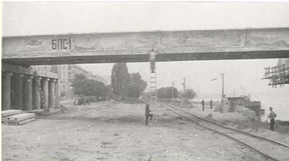
Рис. 2.18. Експериментальна балка прогонової будови - зняття відліків за приладами.
