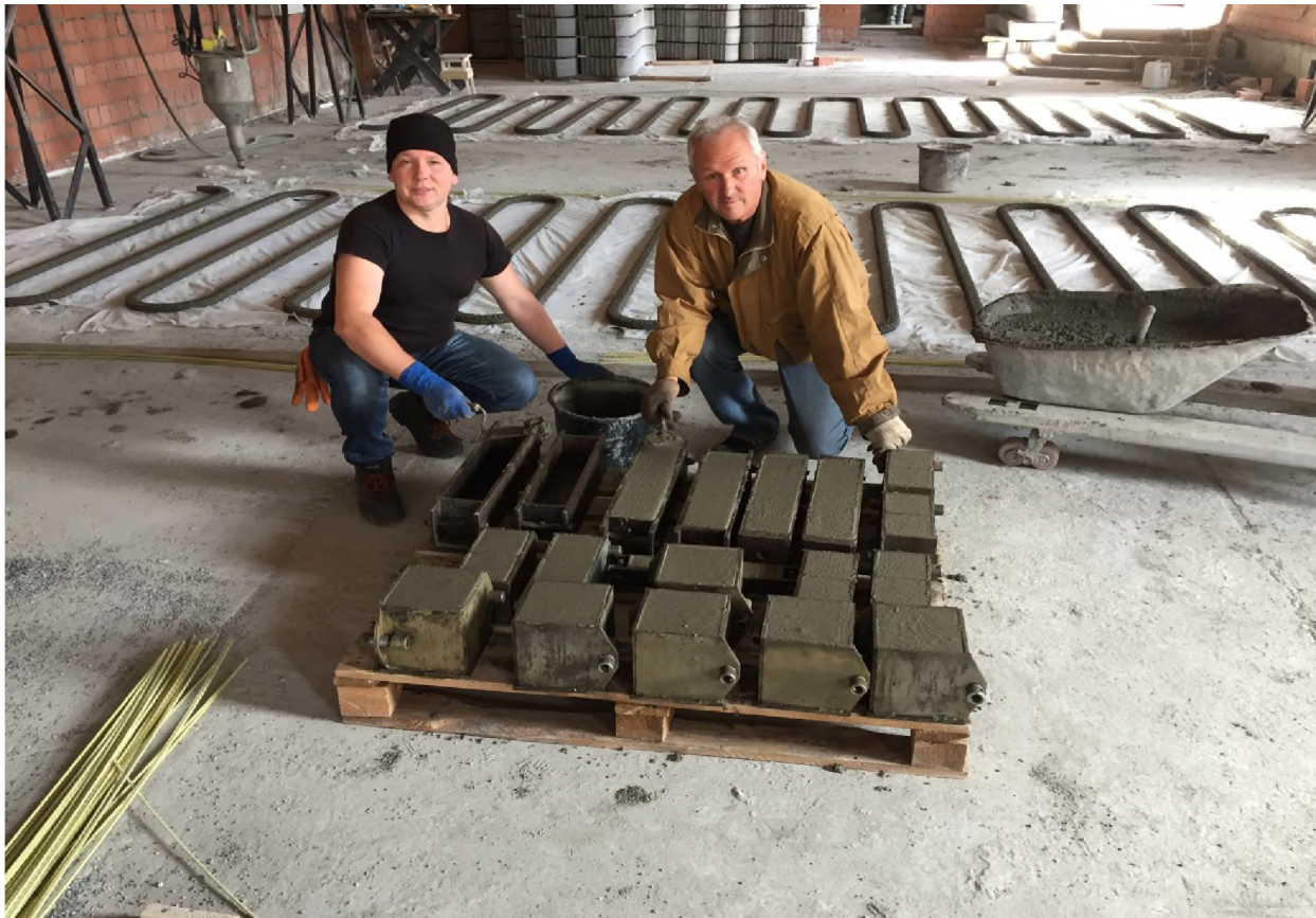
Рис. 4.21. Виготовлення бетонних зразків у цеху по виробництву конструкцій на 3D-принтері.
