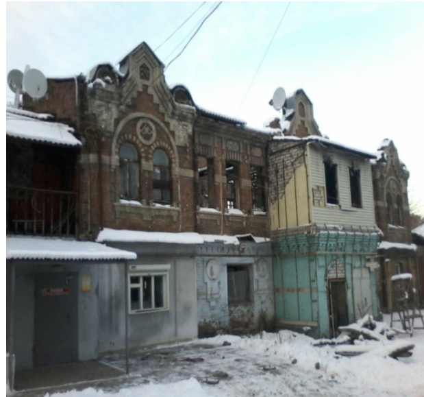
Рис. 2. Ул. Чкалова, дом № 26, корп. 2
