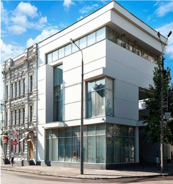
Рисунок 8.1.51 – Виставковий центр "ShowRoom" з адміністративними приміщеннями та рестораном на вул. Європейській, 20а (колишня вул. М. Миронова)
