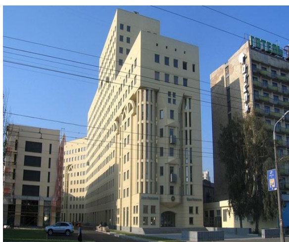
Рисунок 8.1.5 – Житловий комплекс «Будинок Крейніна» на Крутогорному узвозі, 33 (колишня вул. Ф. Рогальова)
