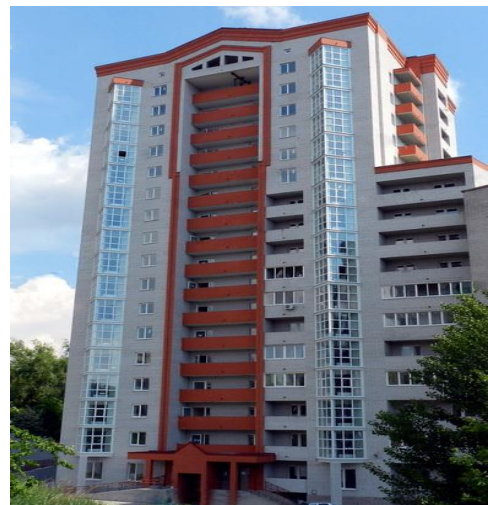
Рисунок 8.2.56 – Житловий будинок на вул. Тополіній, 7а
