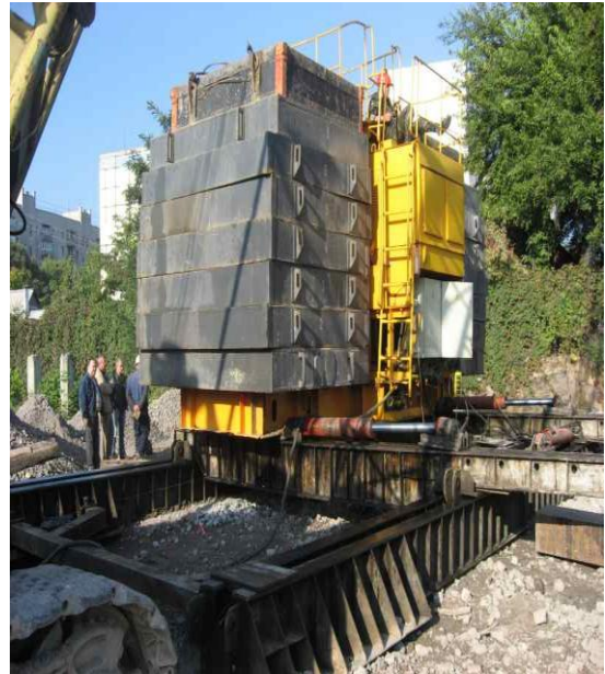
Рисунок 8.1.42 – Багатоповерховий житловий комплекс «Піонер» (будівництво)
