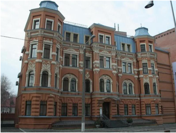
Рисунок 8. 2. 98 – Адміністративна будівля на вул. Південна, 2 (реконструкція)
