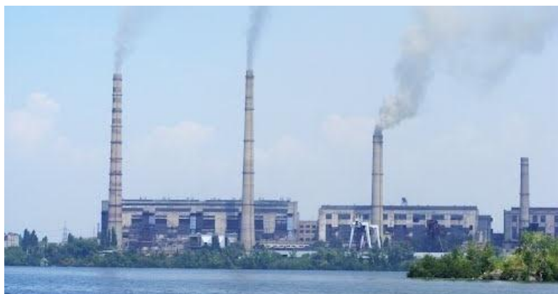
Рисунок 7.9 – Придніпровська ДРЕС ім. 50-річчя Радянської України (нині ПАТ «ДТЕК Придніпровська ТЕС»; вул. Гаванська, 1)
