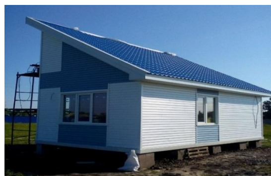
Рисунок 8.2.65 – Котеджне селище «Созидатель-хаус» на території села Спаське (будівництво)
