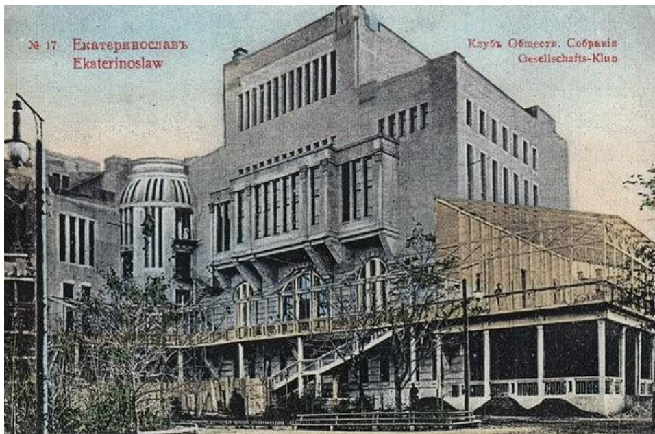
Рисунок 5.23 – Театр-клуб Громадського зібрання в завершальному етапі будівництва. Вид з двору. 1913 рік (нині Дніпропетровська обласна філармонія на вул. Воскресенській, 6). За проектом академіка архітектури А.Гінзбурга. [фото з інтернет ресурсу www.dnepr-philharmonic.com ]
