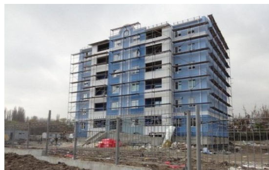
Рисунок 8.2.61 – ЖК «Пролісок» у м. Дніпро на вул. Маршала Судця, 42 (у ході будівництва)
