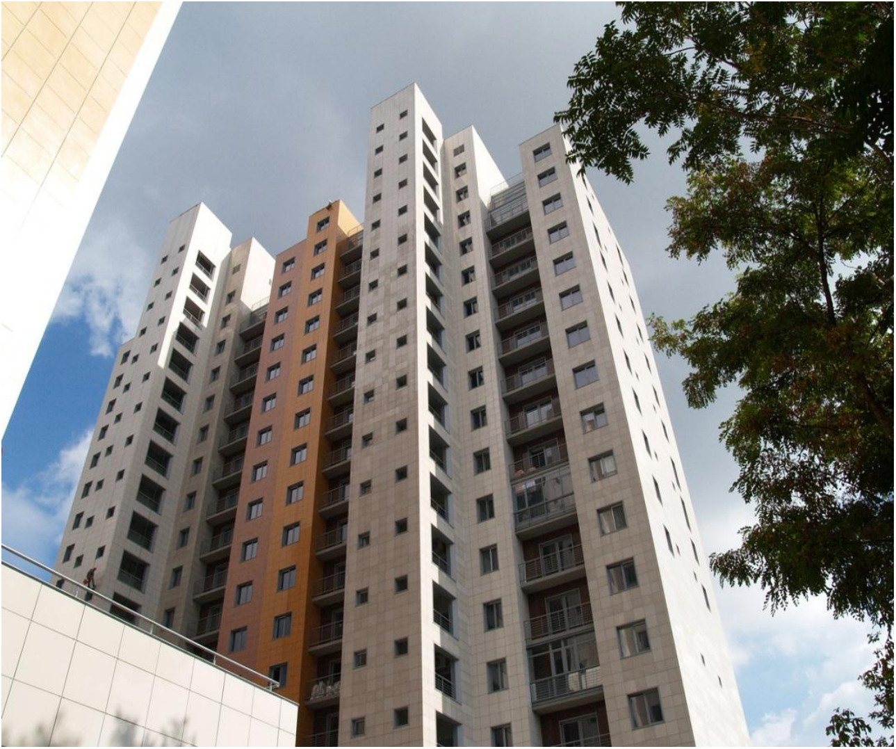
Рисунок 8.1.7 – Житловий комплекс «Дует» на Крутогорному узвозі, 28 (колишня вул. Ф. Рогальова)
