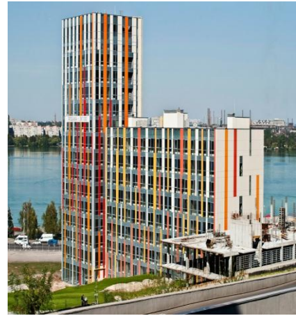
Рисунок 8.2.21 – Житловий комплекс «Фестивальний» на Січеславській Набережній, 47 (колишня Набережна ім. В. Леніна) (буд. №1, буд. №2)
