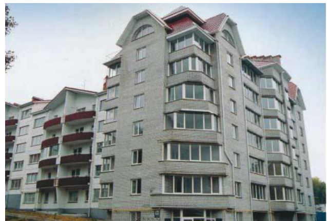
Рисунок 8. 2. 83 – Житловий будинок на вул. Троїцькій, 22а (колишня вул. Червона)
