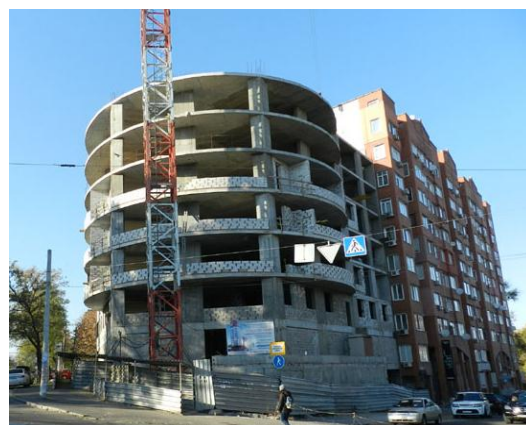
Рисунок 8.2.63 – Багатофункціональний комплекс «Чкаловський» на вул. Виконкомівській, 22/24 (будівництво)
