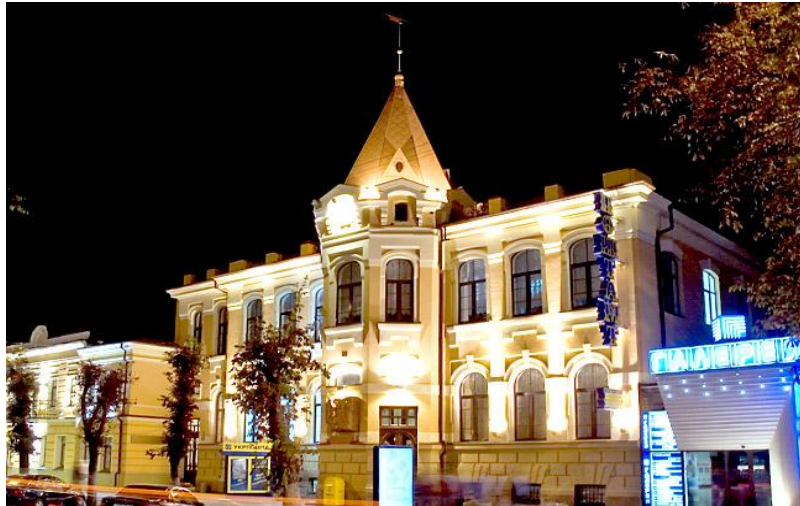
Рисунок 8.2.59 – Відреставрована будівля головноштамту на пр. Д. Яворницького, 62
