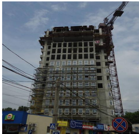
Рисунок 8.2.101 – ЖК Воронцовський у м. Дніпро на вул. Луговській, 225 (у ході будівництва)
