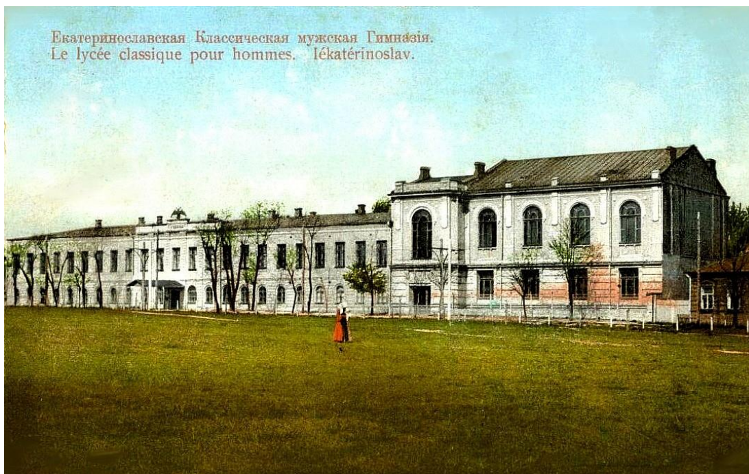
Рисунок 3.15 – Класична чоловіча гімназія у Катеринославі (сучасна адреса — Жовтнева площа, 2), за проектом архітектора І.М. Скотнікова. Нині ця будівля у стилі російського класицизму середини XIX ст. є пам'яткою архітектури національного значення. [з інтернет ресурсу vesti.dp.ua ]
