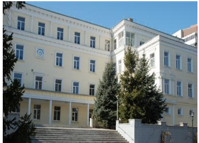
Рисунок 8. 2. 95 – Будівля середньої школи №144 на вул. Менахем-Мендл Шнеєрсона, 1 (колишня вул. К. Мініна)
