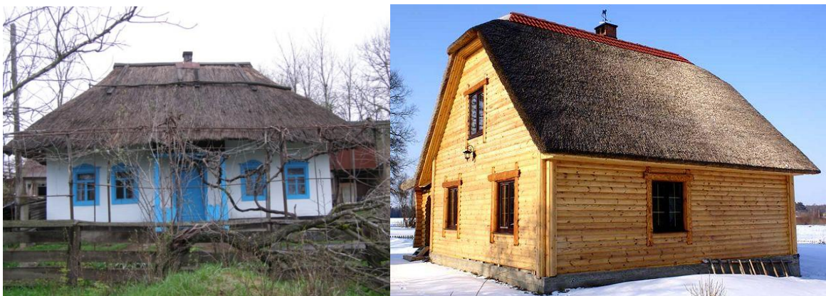
Рис. 4. 23. Солом'яний дах давній і сучасний
