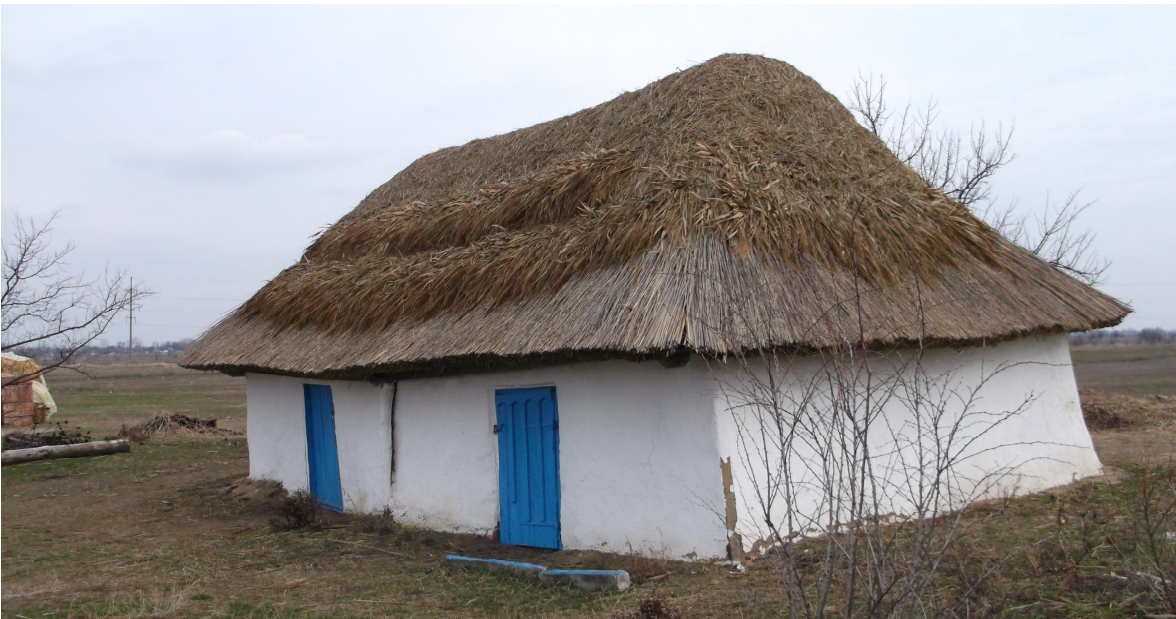
Рис. Д7.16. Повітка, вкрита очеретом
