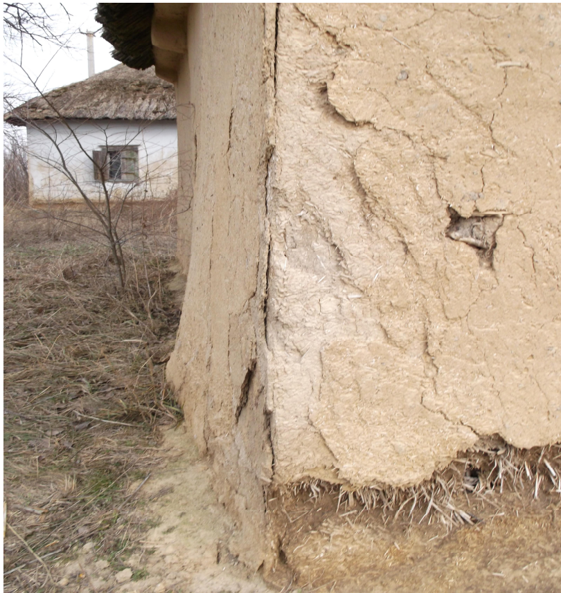
Рис. Д5.11. Причілок валькової хати (на фото добре видно тришарову штукатурку)
