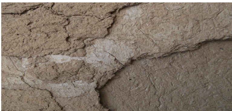
Рис. Д1.25. Штукатурка глиносолом'яним розчином (тришарова)
