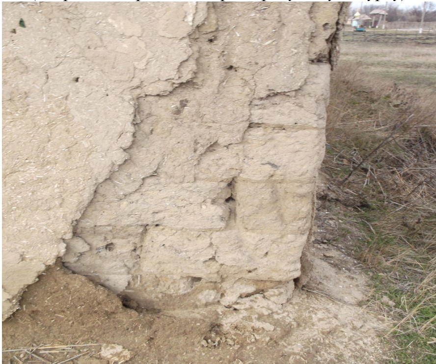
Рис. Д5.11. Причілок валькової хати (на фото добре видно тришарову штукатурку)
