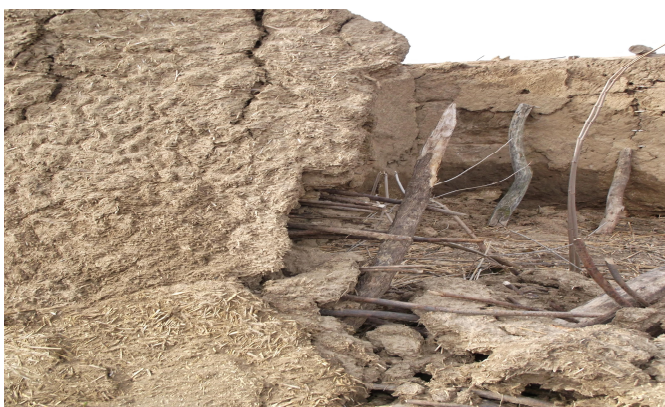
Рис. Д1.19. Залишки хати-мазанки (штукатурка та шпарування)
