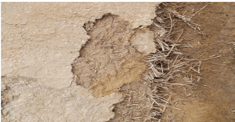
Рис. Д1.18. Штукатурка та шпарування хати
