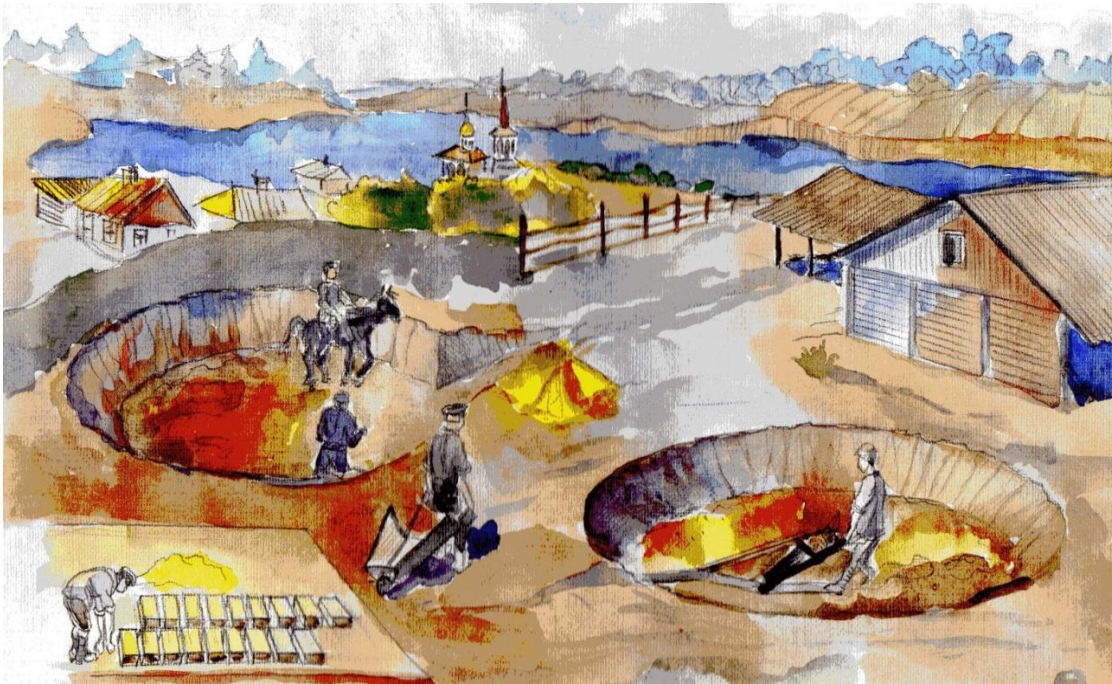
Рис. 4.5. Виготовлення саману (малюнок студента-архітектора Олега Токарева)
