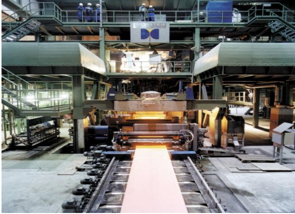
Рис. 4. Упровадження нової технології виробництва металопрокату для будівельних конструкцій на меткомбінаті ПАТ МК «Азовсталь», стан 3000
