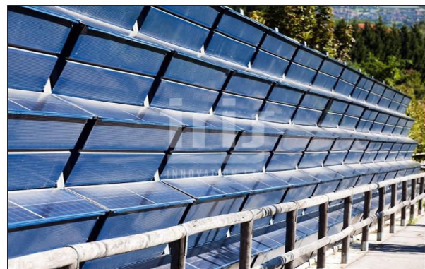
Рис. 3 – Шумопоглинаючий фотоелектричний екран Sound Solar Panel / Noise absorbing photovoltaic screen Sound Solar Panel
