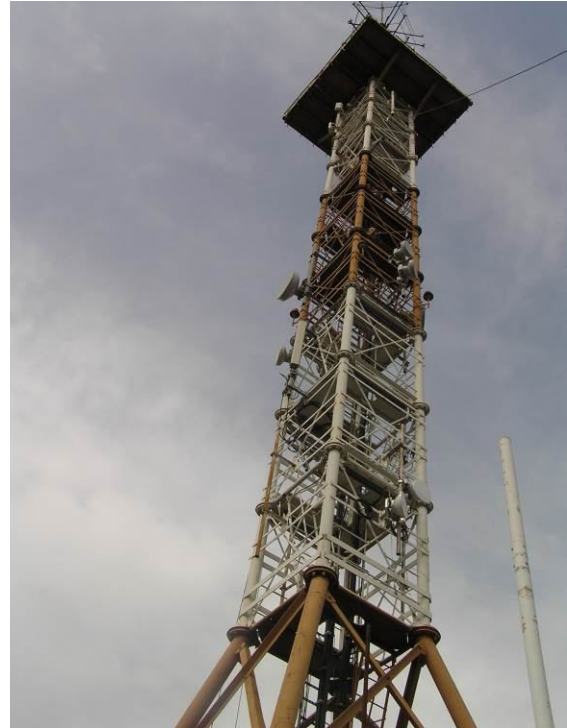
Фото 2. Металлическая телевизионная башня высотой H=32.5 м/
