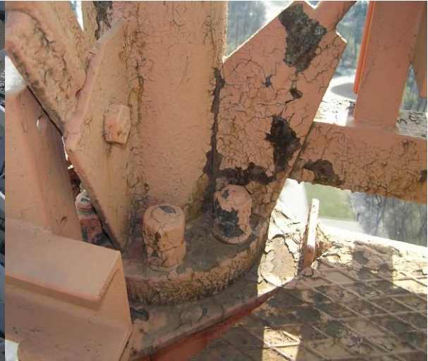
Фото 4. Фланцевое соединение элементов башни на отм. 75.00м /
