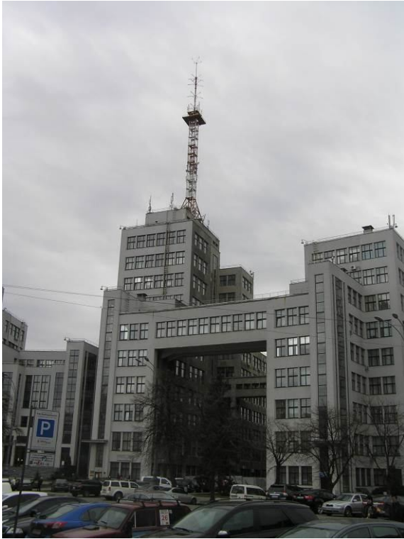
Фото 1. Общий вид башни на крыше здания Госпром / General view of the towers on the roof of Derzhprom
