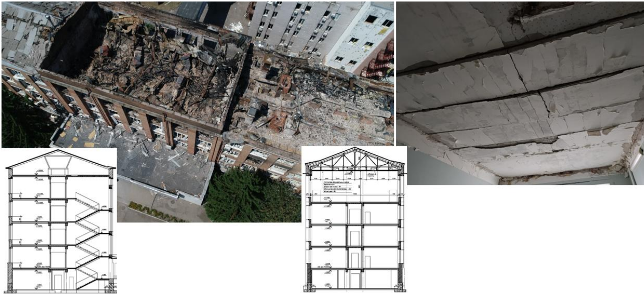
Рис. 2. Схема будівлі № 2, пошкодження плит перекриття, схеми поперечників крайніх частин та середньої
