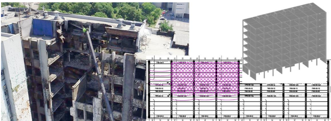
Рис. 1. Схема будівлі № 1, розрахункова модель, типове перекриття
