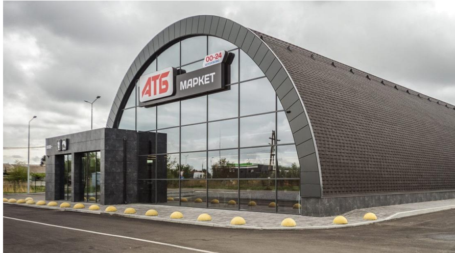
Рис. 1.3 – Магазин АТБ арочного типу (м. Дніпро).
