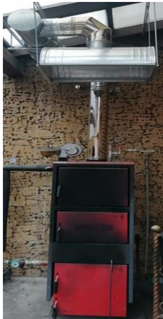
Рис. 2. Твердопаливний котел після відновлення працездатності
