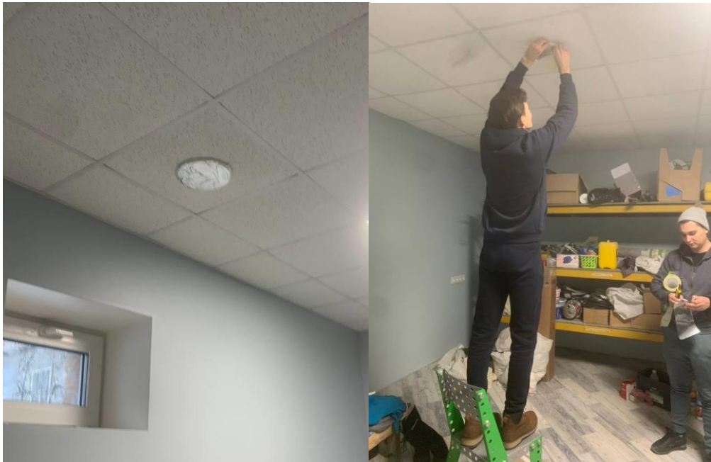
Рис.6.7 Герметизація вентиляції
