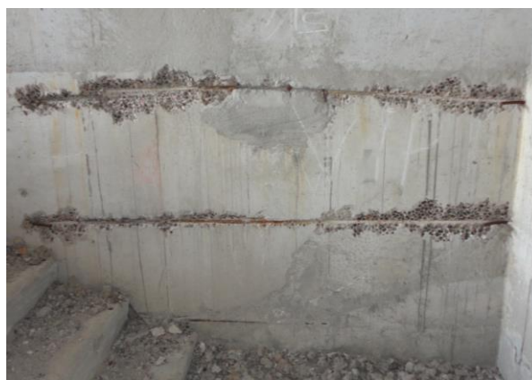
Рис. 5. Руйнування бетону конструкцій стін та вилучення арматури
