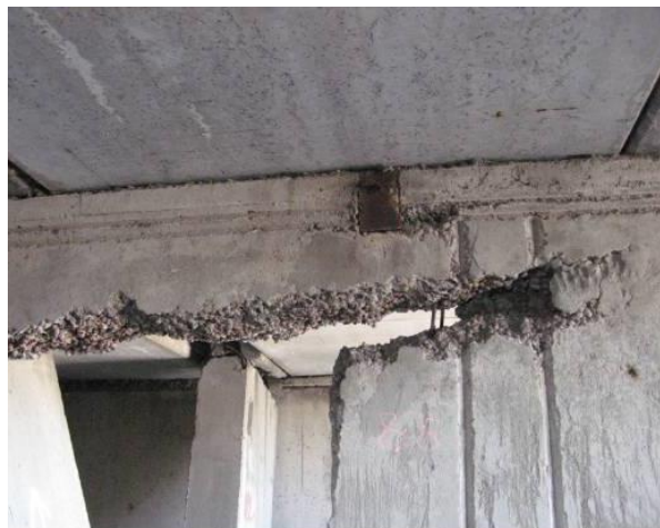
Рис. 4. Руйнування бетону конструкцій стін та вилучення арматури
