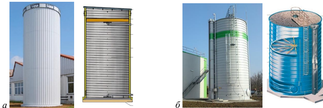
Рис. 3. Спірально-фальцеві ємності: а) теплоаккумуляуючий резервуар; б) газовий накопичувач
