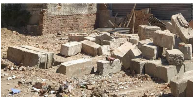
Рис. 2. Демонтовані конструкції пального фундаменту в місці нової забудови, м. Дніпро
