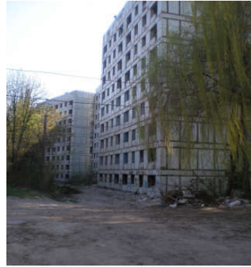
Рисунок 3.6 Покинута будівля №9 (постраждала під час зсуву)
