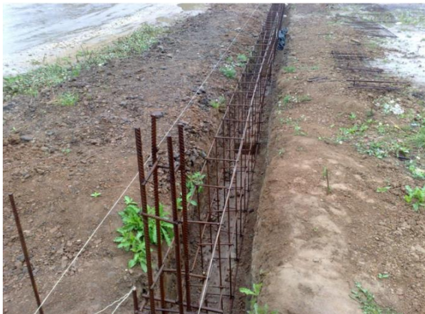
Рис. 1. Зовнішній вигляд стрічкового фундаменту
