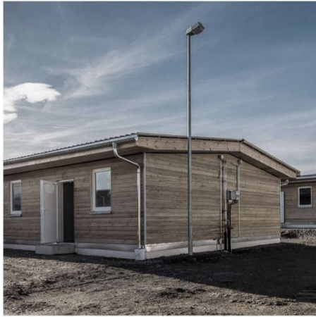
Локація: Хальберштадт, Німеччина Кількість мешканців: 320 чол. Кількість будинків: 8 будинків Метод будівництва: дерев'яний каркас із зовнішнім утепленням стін Житлова площа на одну людину: 6,25 м²/люд
