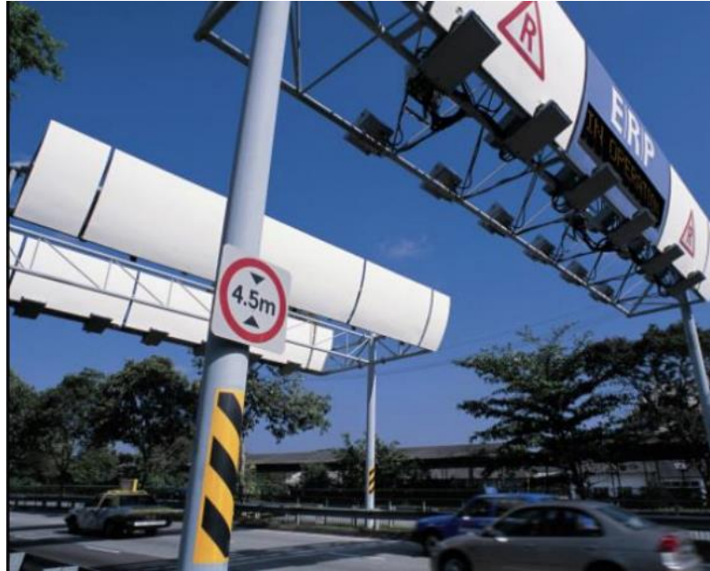
Рис. 2.1. Портал ЕТД у Сінгапурі з датчиками радіочастотної ідентифікації
