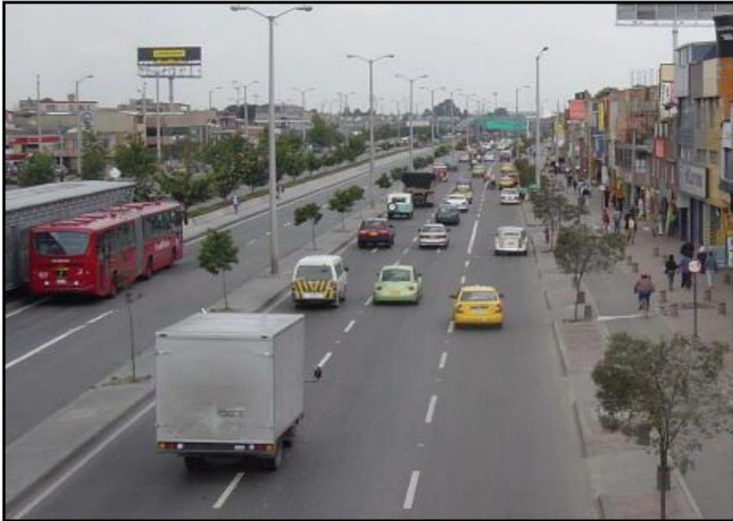
Рис. 2.3. Поділ проїжджої частини TransMilenio
