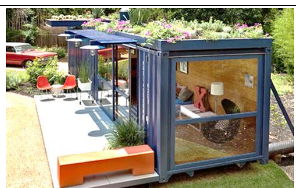
Рис. 221 – Мобільний рекреаційний будинок, вироблений із морського контейнеру (арх. Адам Калкин, США, 2007 р.)
