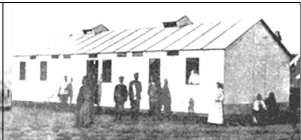
Рис. 148 – Складний дерев'яний щитовий барак (Російсько-японська війна 1904-1905 рр.)
