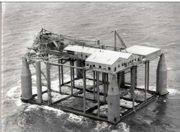
Рис. 311 – Перша у світі плавуча напівзанурена бурова платформа "Blue Water Rig №1" (Мексиканська затока, США, 1961 р.)
