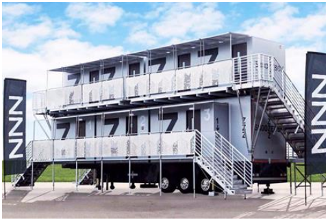
Рис. 228 – Міні-готель із контейнерів «Snoozebox» на базі автомобільного шасі (2013 р., Великобританія)
