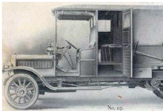
Рис. 163 – Спальне відділення у кабіні вантажівки «Gaggenau» (1910 р).
