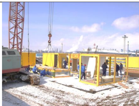
Рис. 306 – Монтаж вахтових будинків збірно-розбірного типу (Росія)
