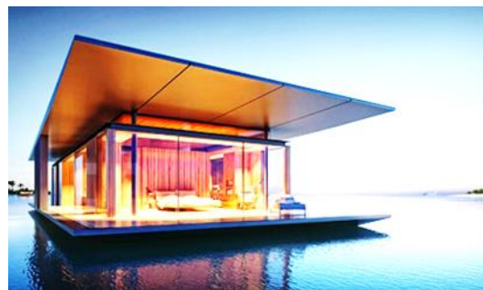
Рис. 273 – Плавучий будинок на понтоні (Сингапур)
