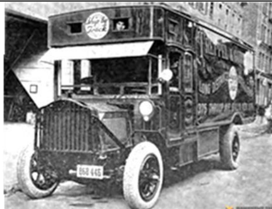
Рис. 164 – Спальний бокс «Шпаківня» вантажівки Packard (1920 р).
