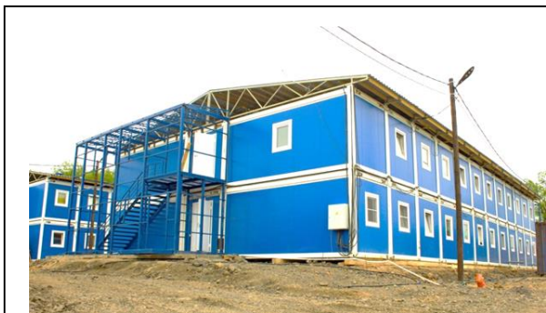
Рис. 305 – Вахтові будинки із збірно-розбірних модулів для ВАО «Транснафта-Далекий Схід» (Росія)
