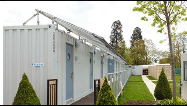
Рис. 229 – Контейнерний готель «Snoozebox» (2012 р., Великобританія)
