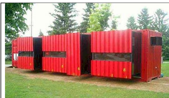
Рис. 329 – Мобільний будинок-трансформер; колишній вантажний контейнер із висувними стінами (США)
