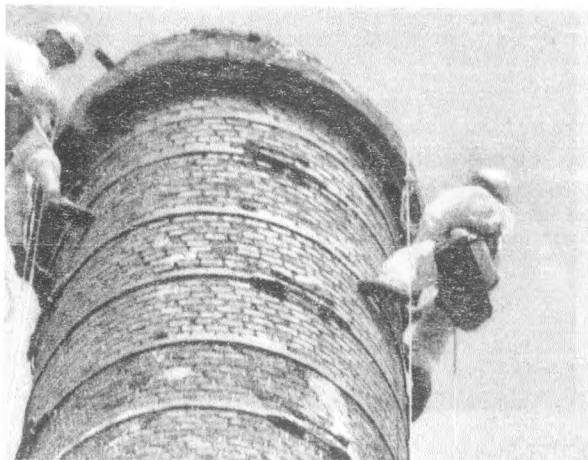
Рис. 3. Обстеження труби альпіністами
