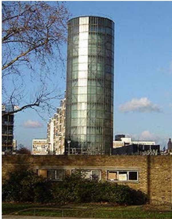
Рис. 4.35. Вежа пароаккумулятора центрального опалення на вул. Сади Черчілля (Садиба, Пімліко, Лондон, Об'єднане Королівство)
