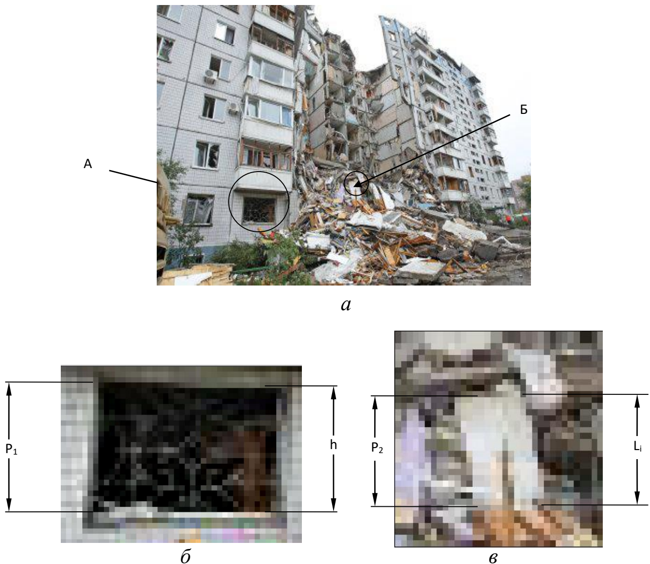
Рис. 3. Обробка отриманих зображень: а – зруйнована будівля і завал, розміри уламків яких визначаються; б – еталонний елемент А будівлі; в – уламок Б, лінійні розміри якого визначаються.
