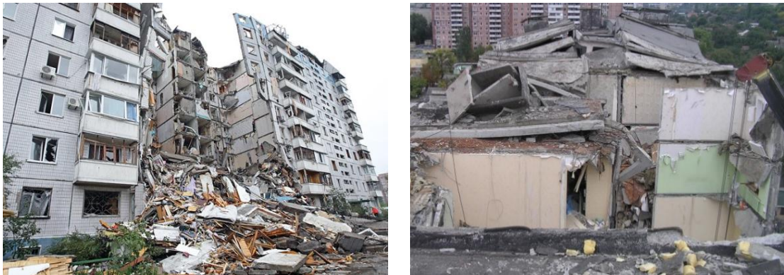
Рис. 9. Зруйнований вибухом газу будинок у Дніпрі (2007 р.): а – фасад; б – покрівля
