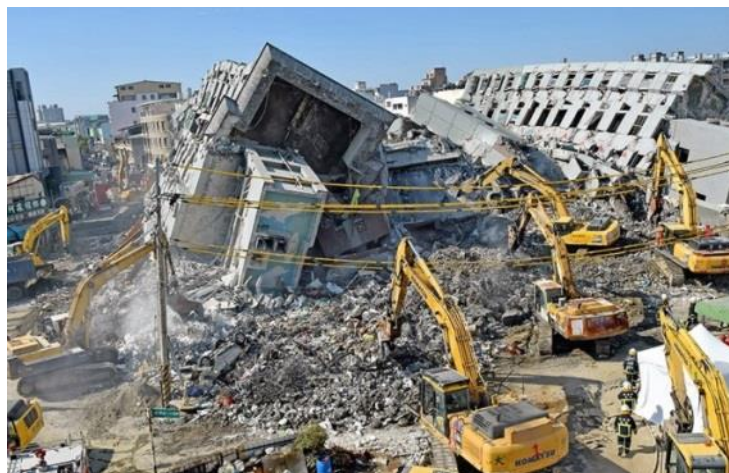
Рис. 15. Розбирання руйнувань одночасним використанням декількох екскаваторів із різним робочим обладнанням
