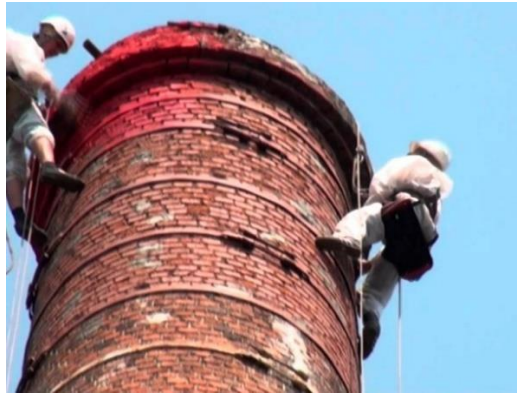
Рис. 8. Обстеження труби альпіністами
