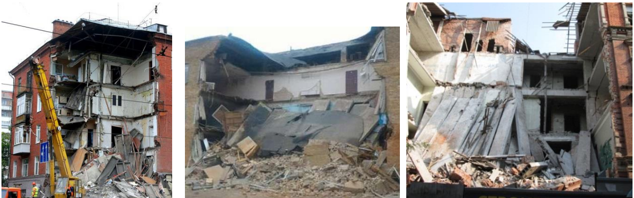
Рис. 10. Зруйновані будинки внаслідок несвоєчасного ремонту: а – м. Шахтинськ (Карагандинська обл., Казахстан, 2017 р.); б – м. Васильків (Київська обл., 2016 р.); в – м. Дніпро, вул. Артема, 28
