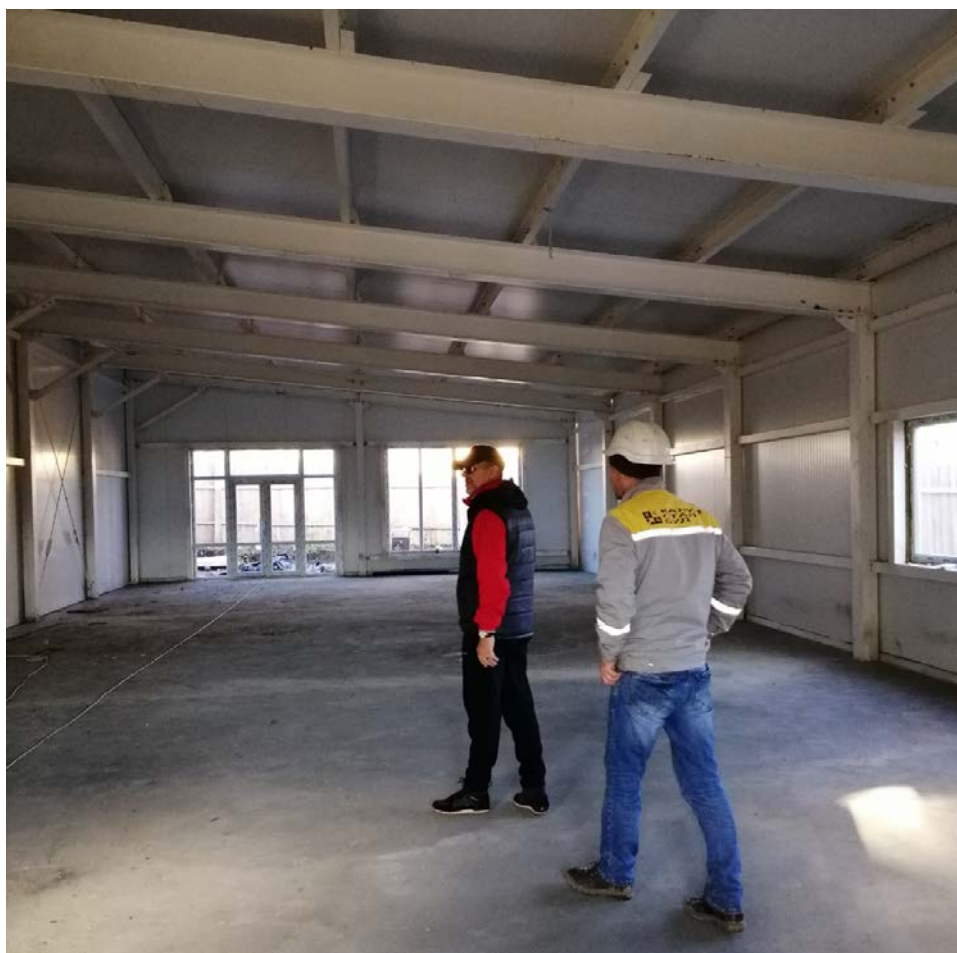
Рис. 4.2 Загальний вигляд приміщення складу на стадії будівництва
