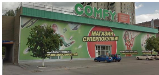
Рис. 1. Двоповерхове приміщення громадського користування із силікатної цегли (пр. Героїв, 1 с)
