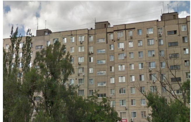
Рис. 5. Дев'ятиповерховий панельний житловий будинок з приміщеннями громадського користування на проспекті Героїв, 19
