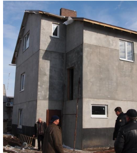
Рис. 2. Будівництво котеджу з тришарових панелей у м. Дніпро
