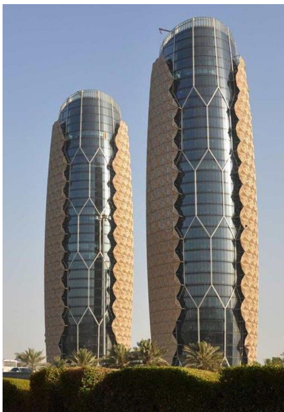
Рис. 29. Башти Aedas Architects Al Bahar в Абу-Дабі – приклад кінетичних фасадів. Парасолькові панелі фасаду відкриваються та закриваються у відповідь на рух сонця, захищаючи користувачів будівлі від спеки та відблисків, зменшуючи потребу в кондиціонуванні повітря та роблячи будівлю більш стійкою. Самі панелі не тільки естетичні та зіркоподібні за дизайном, а й навіяні традиційними ісламськими системами затінення, які також поважають культурну спадщину
