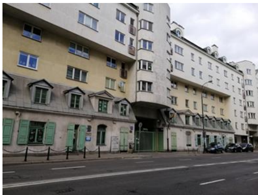
Рис. 6. Архітектурна маска як збережений фасад старовинної будівлі на фасаді нової будівлі, збудованої в нейтральному стилі, або, інакше у стилі будівлі-пломби. Варшава
