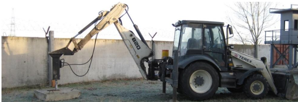
Рис. 5. Встановлення бетонолома та створення динамічного впливу
