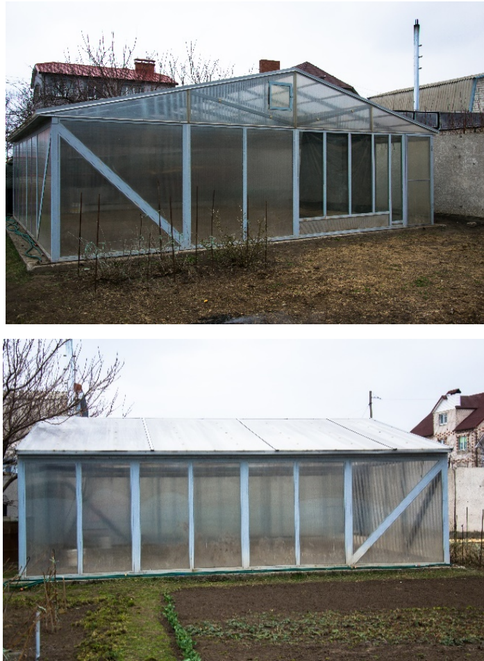
Рисунок 4.1 – Загальний вигляд експериментальної теплиці
