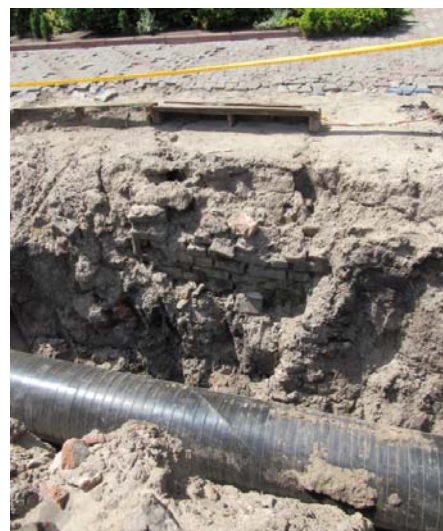
Рис. 11. Залишки зливоприймачів, виявлені під час земляних робіт на площі Шевченка перед центральним входом у парк ім. Т. Г. Шевченка
