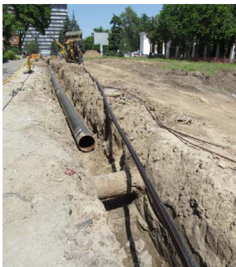
Рис. 10. Відсутній на схемах, однак виявлений під час земляних робіт фрагмент трубопроводу ймовірно зливової каналізації на площі Шевченка перед центральним входом у парк ім. Т. Г. Шевченка
