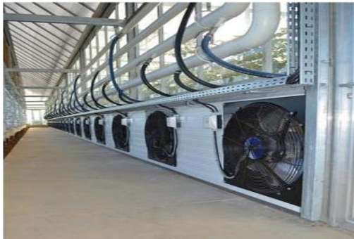
Рис. 2. Вентиляційний блок напівзакритої теплиці : зліва зовнішня стіна з «мокрими матрасами»; справа – стіна (перегородка) теплиці з вентиляторами на кожен ряд рослин, підвідними трубопроводами систем опалення, а також гнучкі рукави підключення нижнього (труборейкового) опалення
