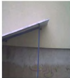
Рис. 3.5. Підвищені тепловитрати цокольної частини будівлі внаслідок недостатньої ізоляції: а) інфрачервоне зображення; б) фото фасаду
