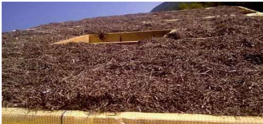
Рис. 4.3. Натуральний утеплювач камка, який робиться з морських водоростей
