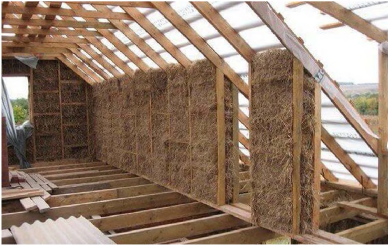
Рис. 4.1. Зведення дерев'яного каркасу з утепленням соломною
