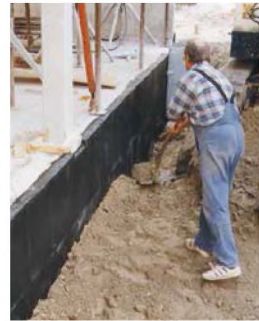
Рис. 3.6. Теплоізоляція заглибленої частини
