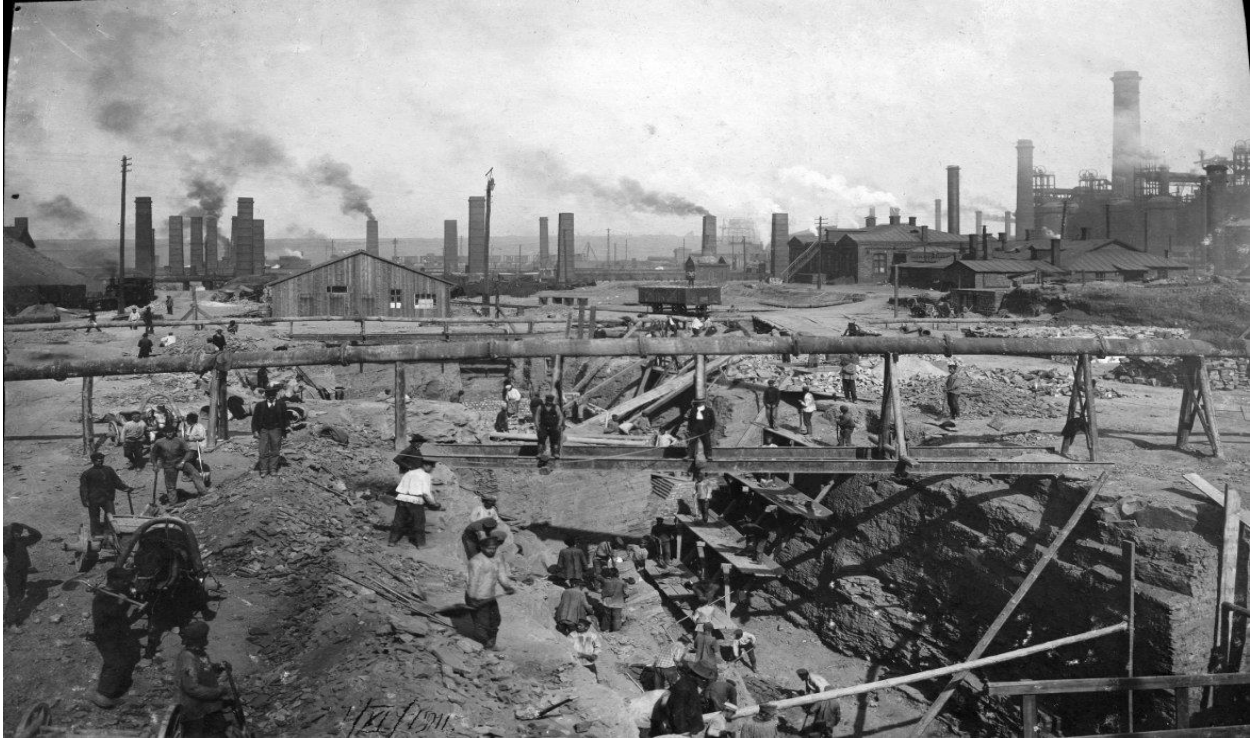
Рис. 62. Робочі будні Юзівського заводу
