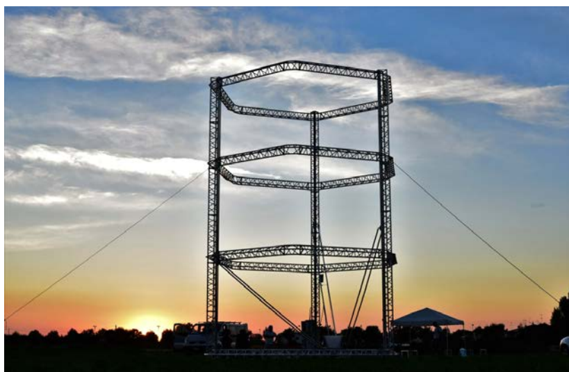
Рис. 1.17. Будівельний 3D - принтер The BigDelta.
