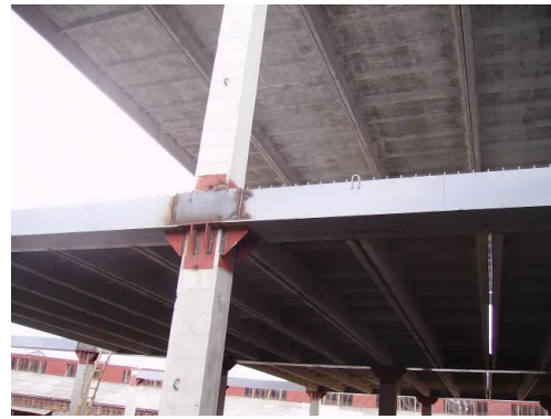
Рис. 3. Виробнича будівля із сталезалізобетонним перекриттям із застосуванням ригелів із зовнішнім листовим армуванням / Industrial building with composite steel concrete ceiling with external reinforced beams
