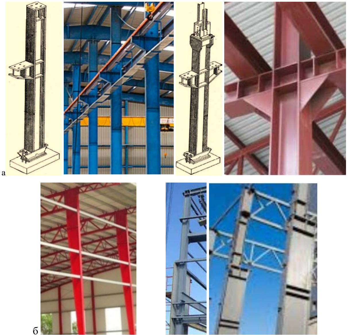
Рис. 3.1.55 Конструктивні схеми колон суцільного перерізу:
