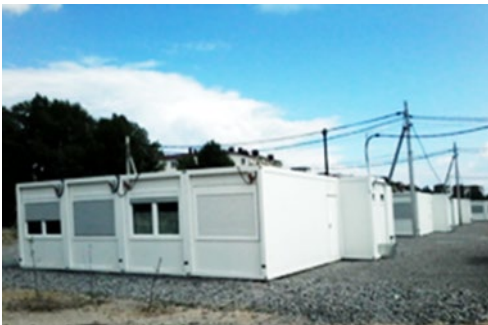
Рисунок 6.19 – Мобільний будинок блок-контейнерного типу у модульному містечку для біженців (м. Дніпро, Україна)
