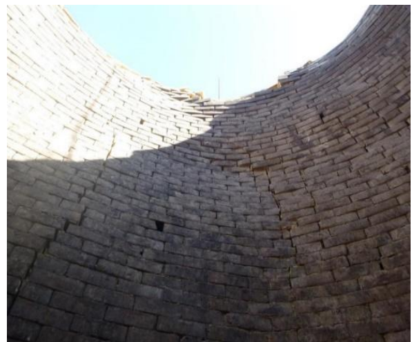
Рис. 5. Випинання (утрата стійкості) кладки футеровки димової труби
