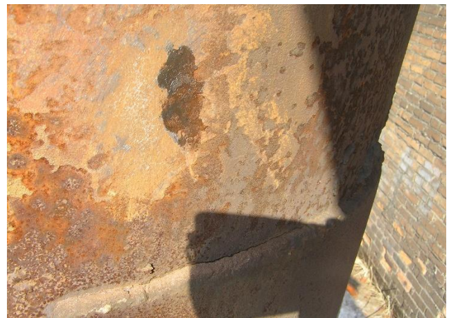
Рис. 3. Тріщини в основному металі, зварних швах і навколошовній зоні
