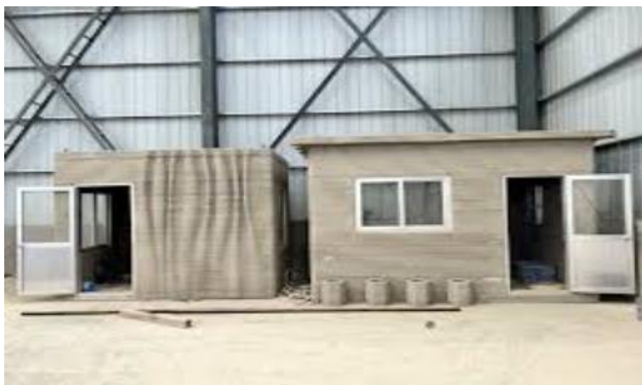
Рис. 3. Будівля, створена з використанням технології 3D-друку
