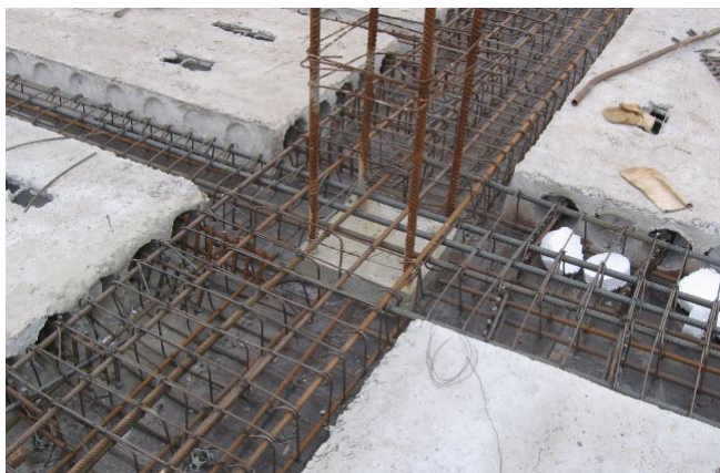
Рис. 1. Монтаж збірно-монолітного перекриття / Fig. 1. Mounting of monolithic overlappings
