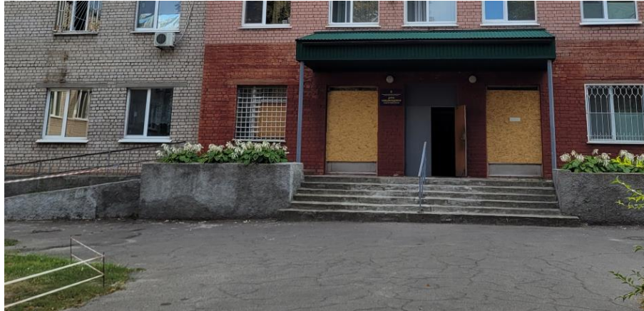
Рис. 1. Вхід до будівлі до початку реконструкції
