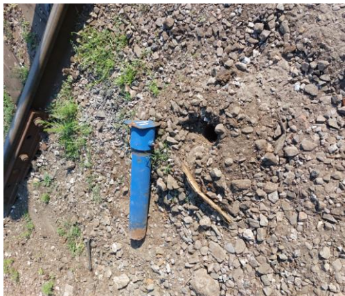
Рис. Пошкоджена режимна свердловина одному з ОЕЗ
