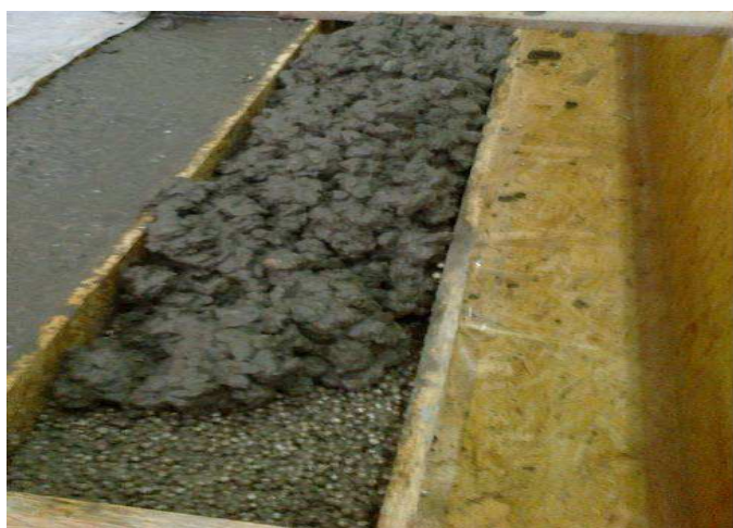
Рис.3.2. Процесс укладки верхнего слоя трехслойных элементов после технологической паузы
