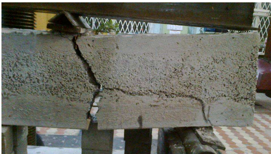
Рис 3.10. Фото балки 4-й серии после разрушения.
